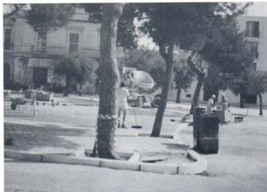
Una fase dei lavori in Piazza XX Settembre
