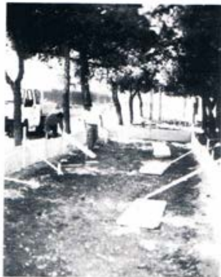
Costruzione del campo di bocce
