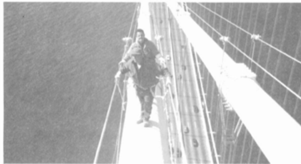
NELLA FOTO: VEDUTA DALL'ALTO DEI CAVI DEL VERRAZANO
